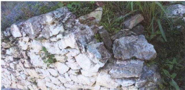
Foto 5: MURO DAÑADO DESPUÉS DE DERRUMBE
