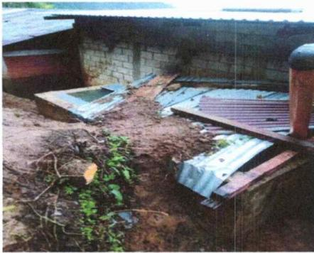
Foto 3: DERRUMBE EN PARTE TRASERA DE MÓDULO DE AULAS
