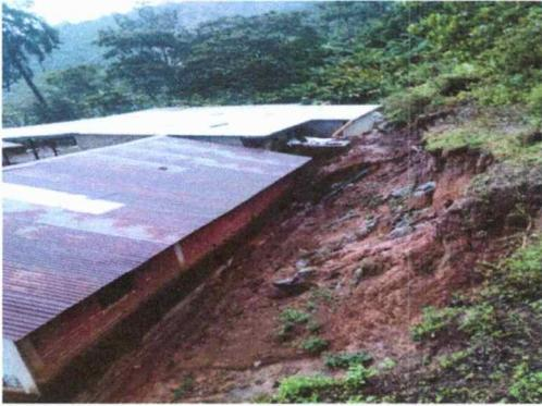
Foto 1: DERRUMBE EN PARTE TRASERA DE MÓDULO DE AULAS
